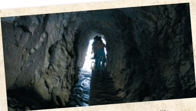
Gefährliche Stellen wurden mit Stollen umgangen.
